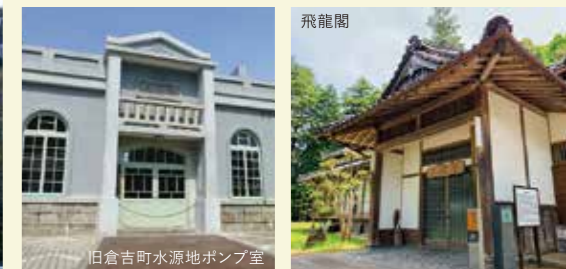
旧倉吉町水源地ポンプ室
